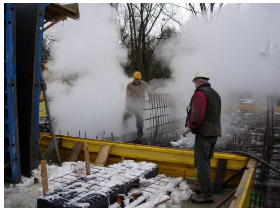
Dégel / Réchauffage avant coulage
