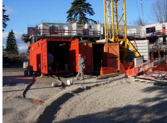
Injection de la vapeur dans les agrégats par le sol
