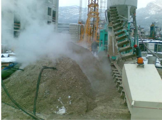
Injection de la vapeur dans les agrégats par lances spéciales (dégel /réchauffage des agrégats)
