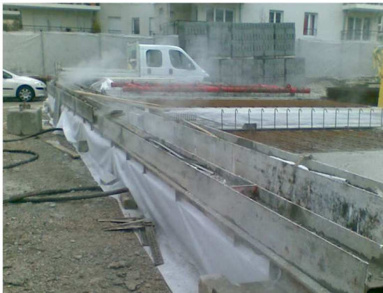
Injection de la vapeur sous table de préfa sur le chantier
