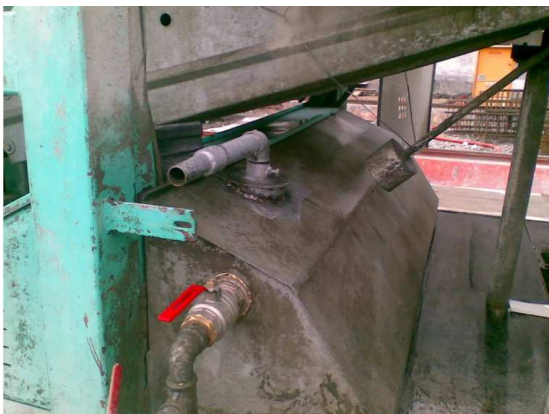
Injection de la vapeur dans la réserve à eau
