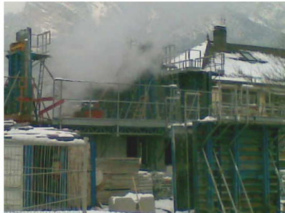
Chauffage des banches avant coulage
